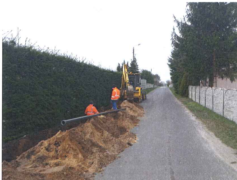
Zdj. Prace przy wymianie sieci wodociągowej na ul. Wolności we Włoszakowicach
