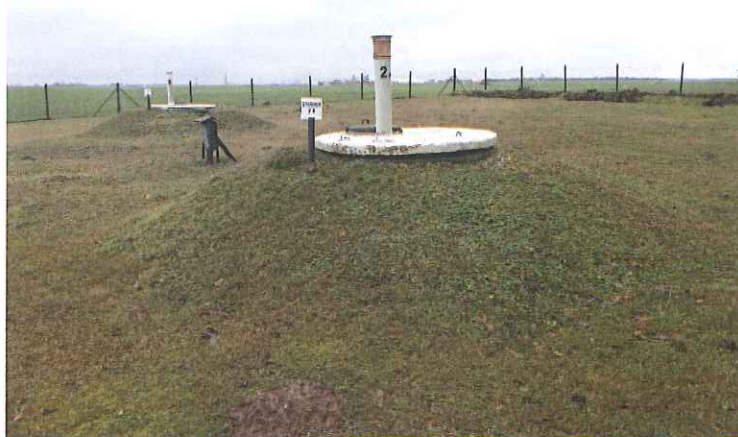
Zdj. Remontowana studnia głębinowa w Ujazdowie.
