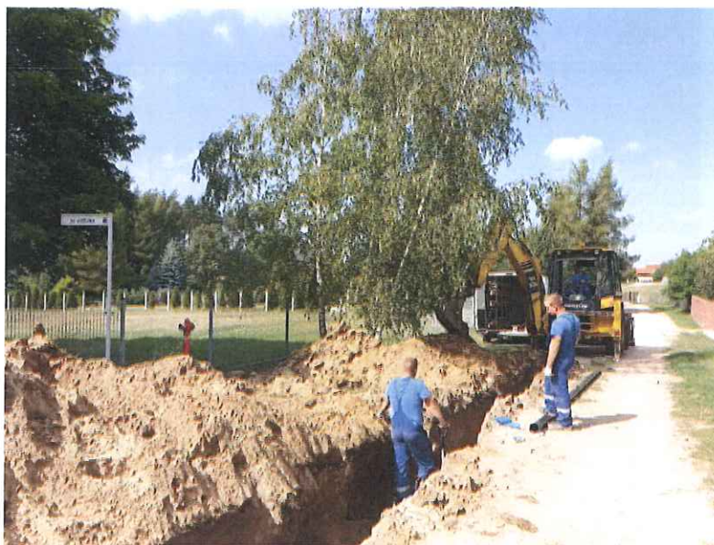
Zdj. Prace budowlane na ul. Jodłowej we Włoszakowicach
