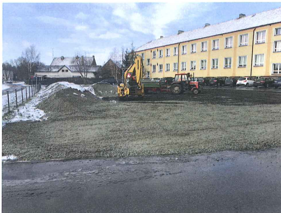
Zdj. Prace ziemne przy utwardzaniu parkingu Włoszakowice ul. Myśliwska.
