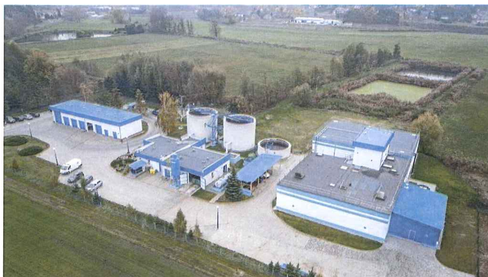
Zdj. Widok zmodernizowanej oczyszczalni ścieków w Grotnikach z lotu ptaka
