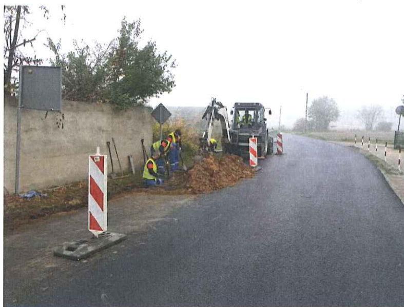
Zdj. Prace przy wymianie sieci wodociągowej w Sądzi
