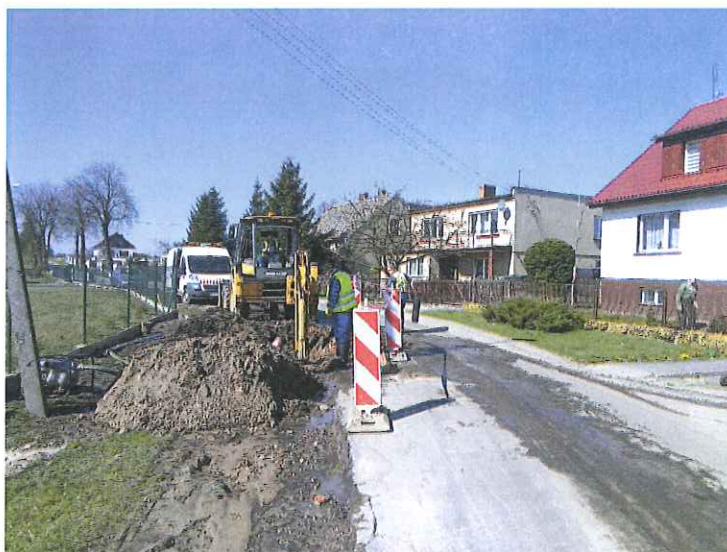
Zdj. Prace przy budowie sieci wodociągowej w Krzycku Wielkim ul. M. Górnego
