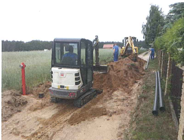
Zdj. Prace przy budowie sieci wodociągowej w Dominicach Osiedle I (cz.II)
