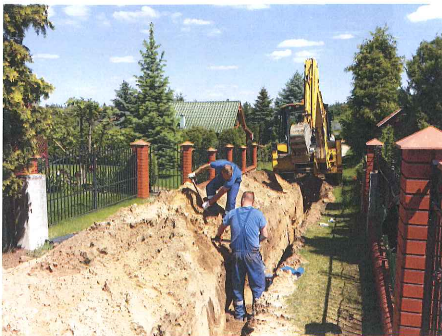
Zdj. Rozbudowa sieci wodociągowej w Dominicach.
