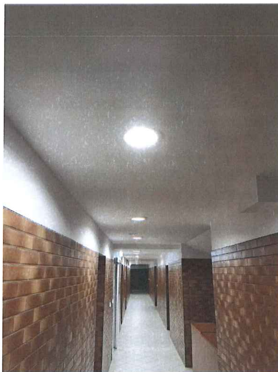
Zdj. Wymiana oświetlenia
