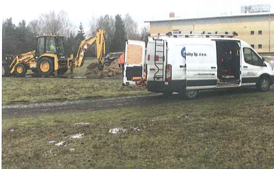
Zdj. Budowa sieci kanalizacji deszczowej stadionu lekkoatletycznego.
