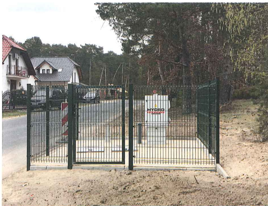
Zdj. Wyremontowana pompownia ścieków P-19
