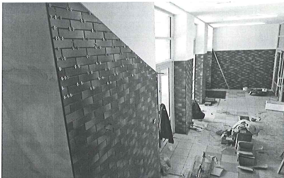
Montaż płytek w łączniku
