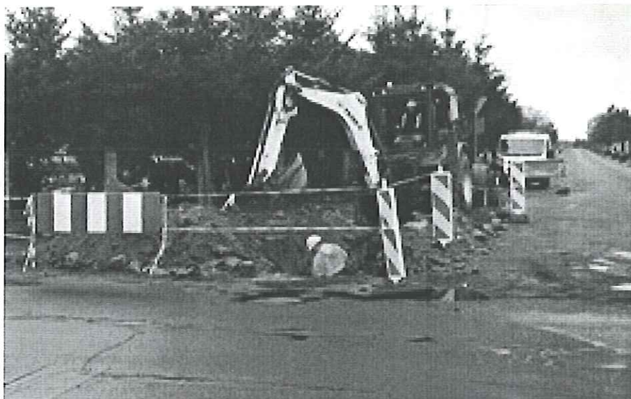
Prace budowlane na ul. Wolsztyńskiej we Włoszakowicach
