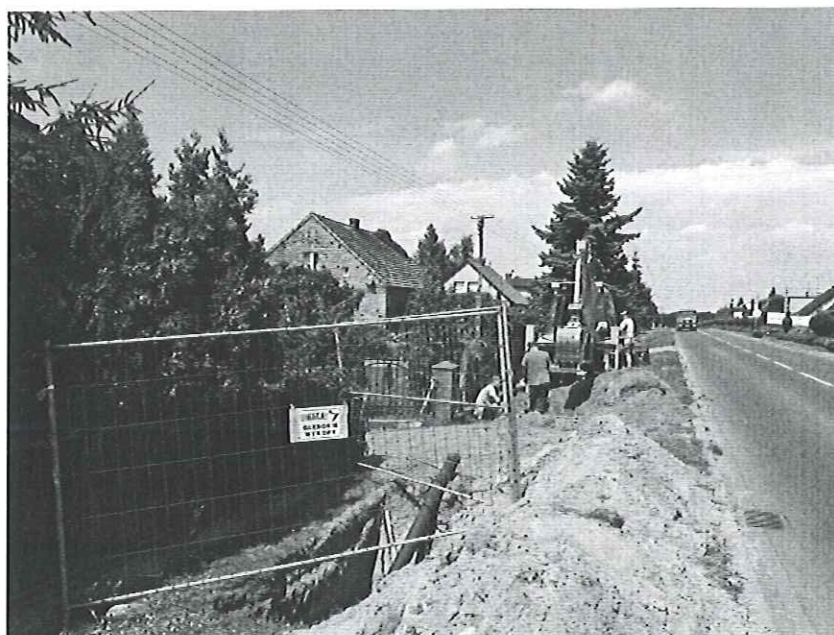
Prace budowlane na ul Leszczyńskiej we Włoszakowicach
