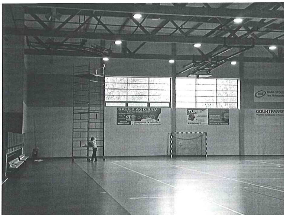
Montaż oświetlenia ledowego
