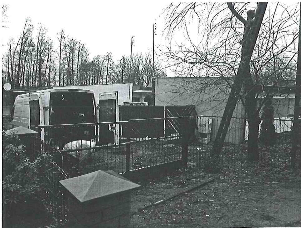
Prace modernizacyjne pompowni ścieków OW LOK
