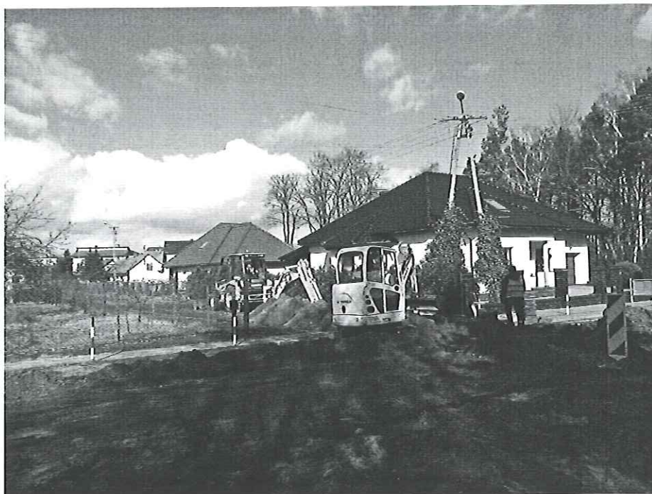
Prace budowlane na ul Zalesie we Włoszakowicach.
