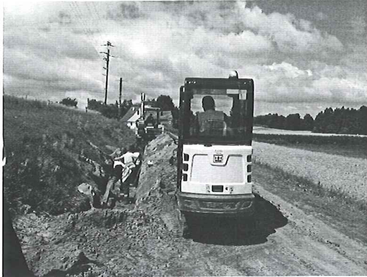
Prace budowlane na ul. Spokojnej we Włoszakowicach
