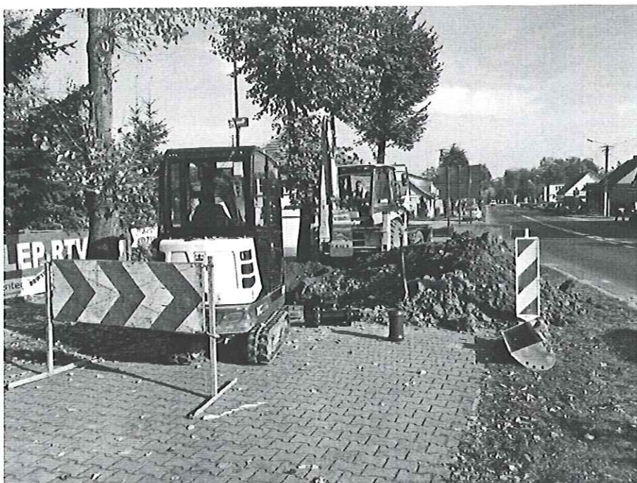
Prace budowlane przy wymianie i budowie sieci na ul. K.Kurpińskiego we Włoszakowicach
