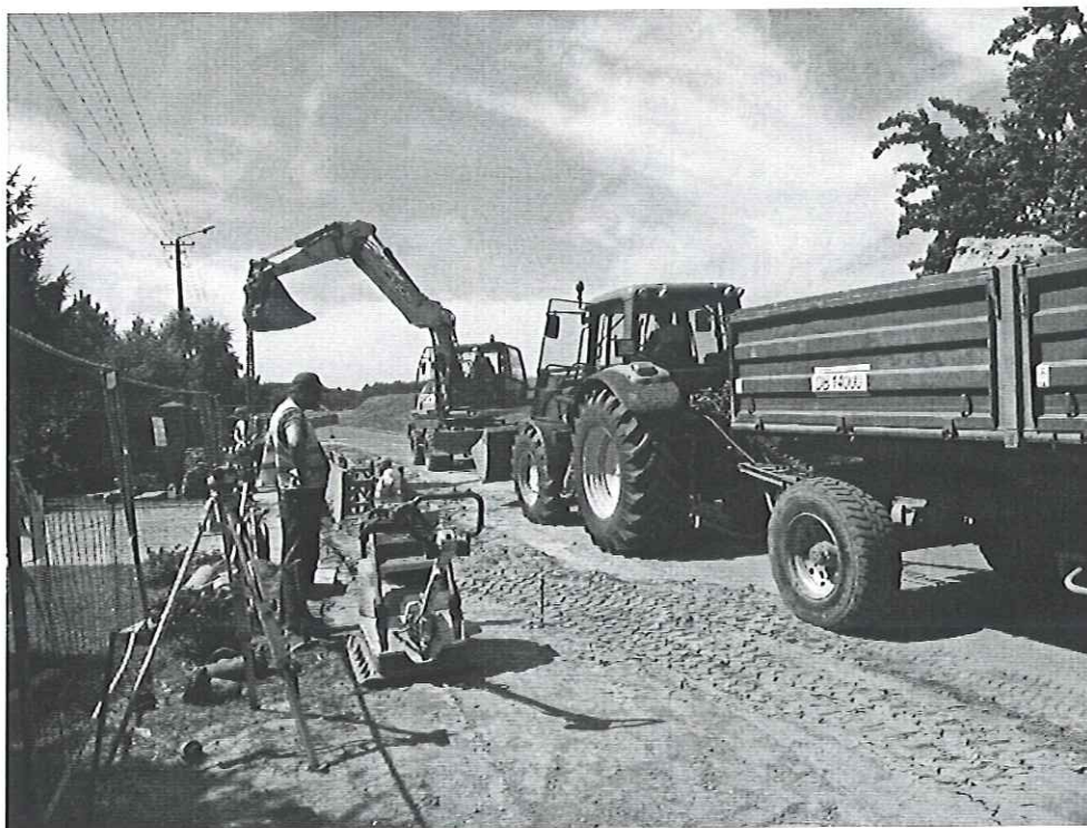
Budowa kanalizacji sanitarnej w Krzycku Wielkim
