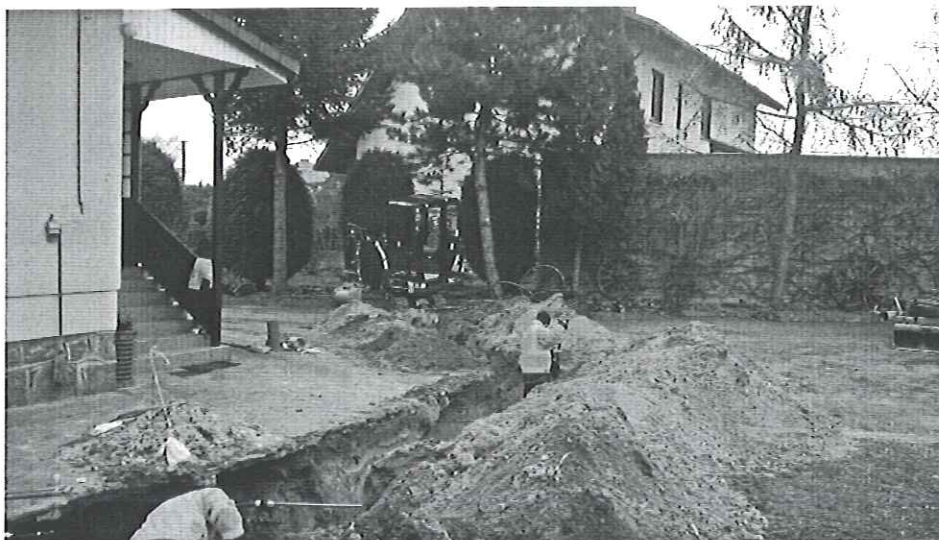
Wymiana przyłącza wodociągowego
