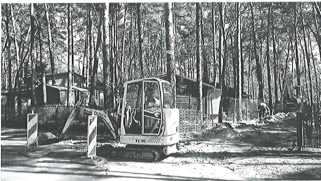
Budowa przyłącza wodociągowego
