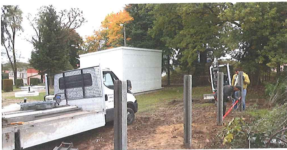
15. Remont ogrodzenia na stacji uzdatniania wody we Włoszakowicach.
